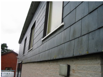
Asbestos siding
