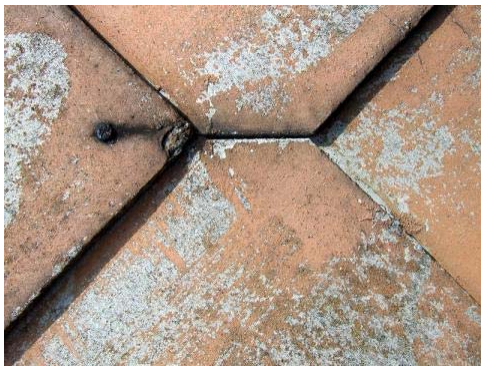
Asbestos tiles
